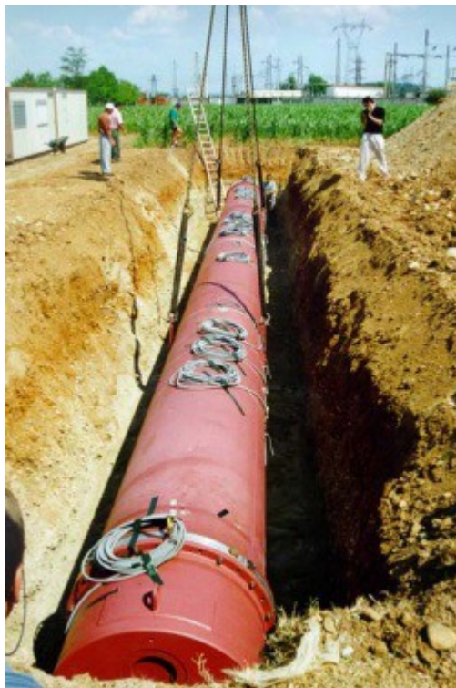
Enfouissement d'un câble à haute tension
