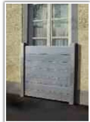
Exemple de batardeau en place
