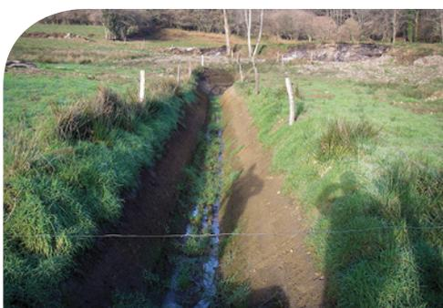
Curage excessif constituant un recalibrage du cours d'eau
