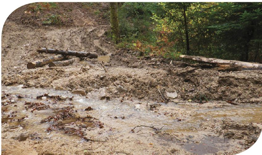
Travaux réalisés à proximité du cours d'eau sans mise en place de mesures visant à limiter les départs de sédiments avec passages d'engins dans le cours d'eau en dehors de toute zone aménagée à cet effet
