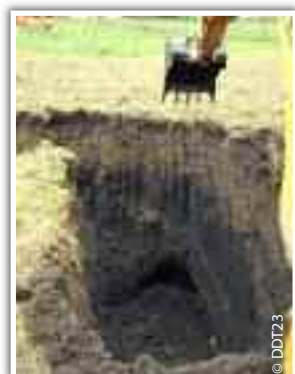
Sécurisation d'un fontis à Lavaveix-les-Mines en 2008...
