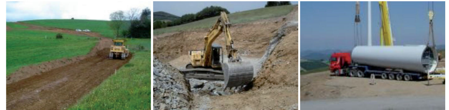
Photographie 107 : Illustration d'un chantier éolien
