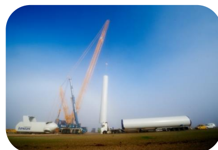
Livraison et Montage des tronçons de mâts
