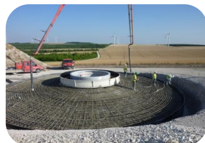
Coulage de la fondation
