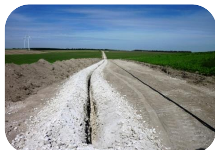
Réalisation des pistes et du câblage
