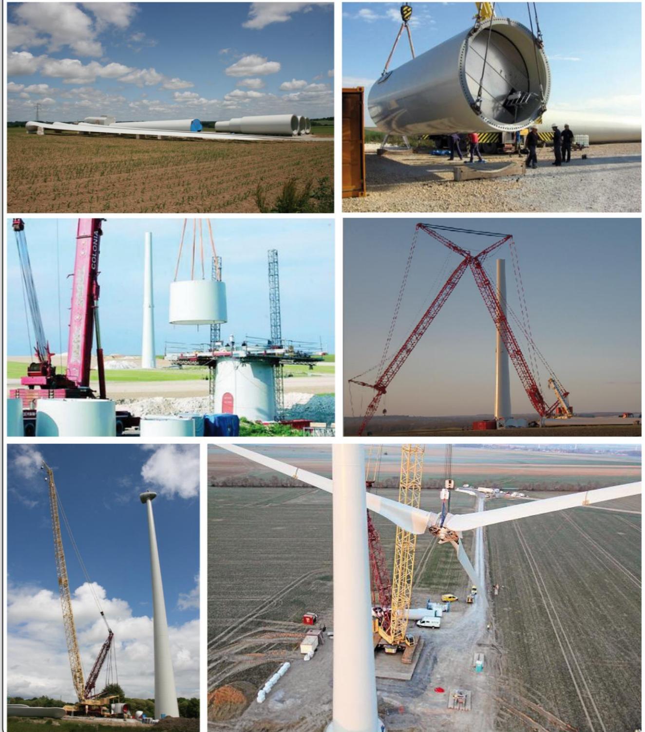
Montage d'une éolienne
