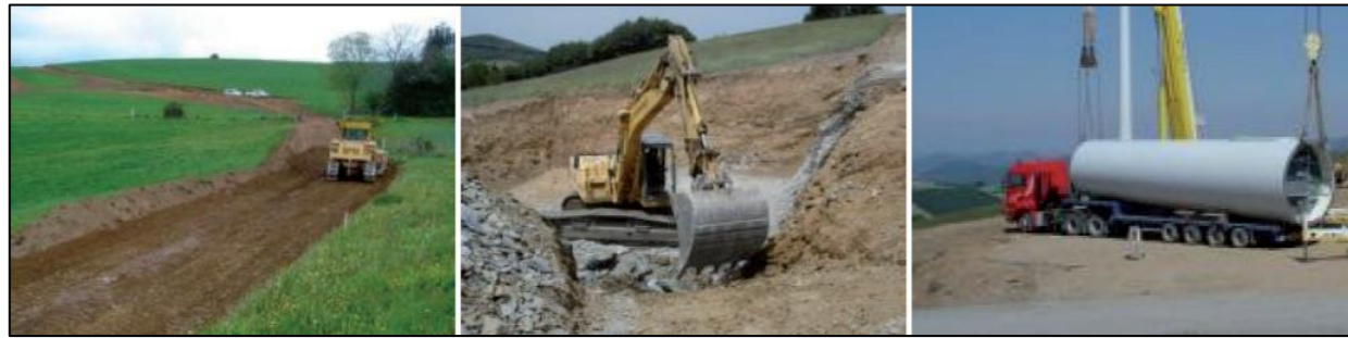
Photographie 54 : Illustrations d'un chantier éolien
