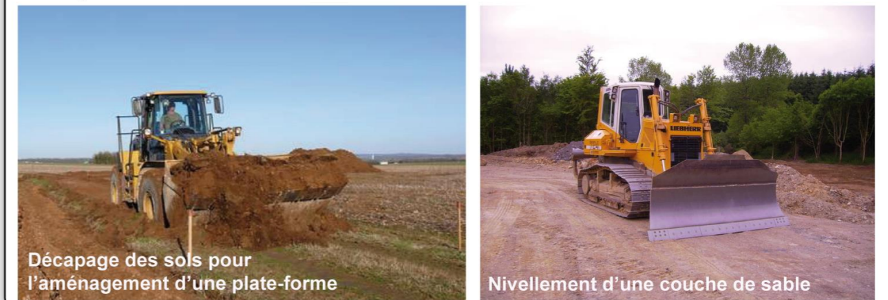
Photographie 47 : Exemples d'engins de travaux de VRD
