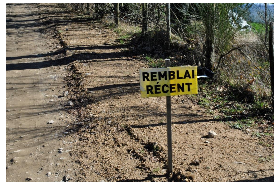
Photographie 52 : Exemple de remblai des tranchées électriques le long d'une piste
