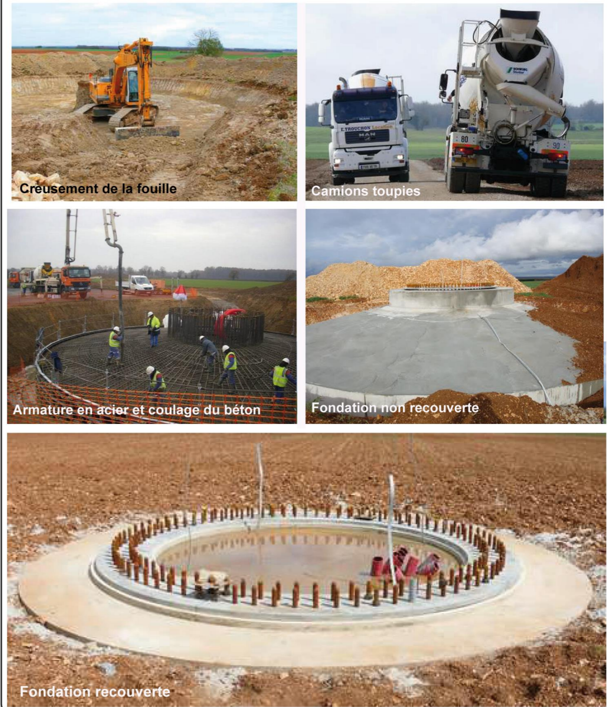
Photographie 48 : Etapes de réalisation d'une fondation d'éolienne
