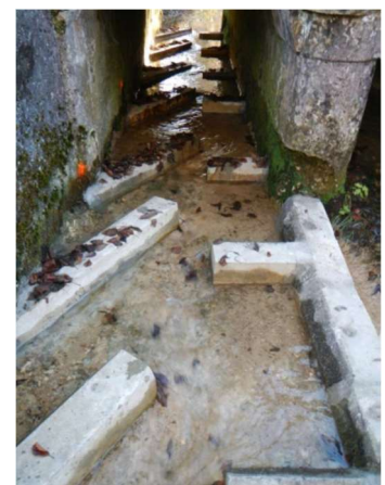
Illustration 25 : Exemple de barrettes offsets dans un ouvrage
