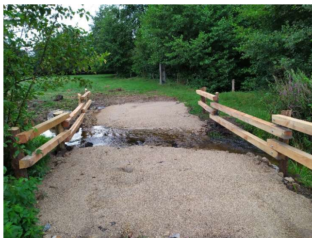
Illustration 11 : Réalisation d'un passage à gué sur la Leyrenne (crédit photo : CCCSO)
