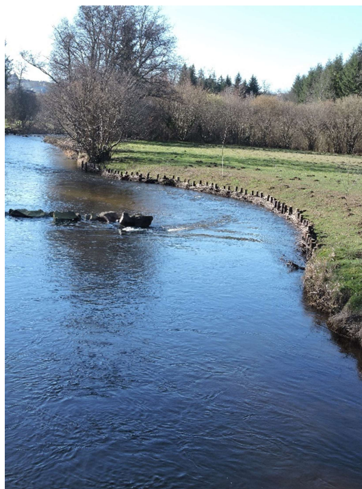
Illustration 13 : Restauration de berge par tressage sur le Thaurion (crédit photo : CCCSO)
