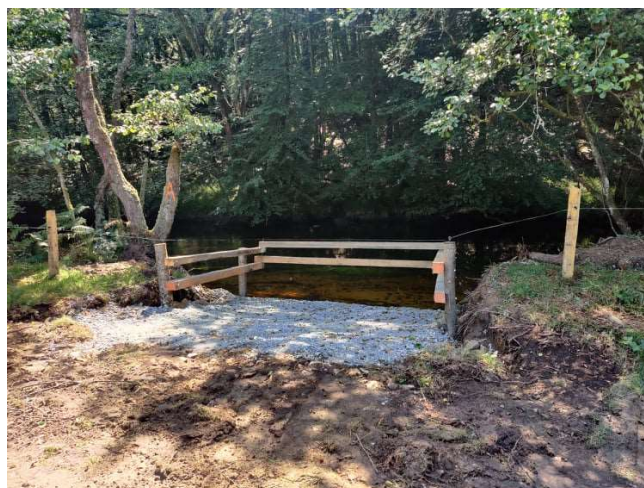
Illustration 4 : Implantation d'un abreuvoir en berge sur un affluent de la Maulde (crédit photo : CCCSO)
