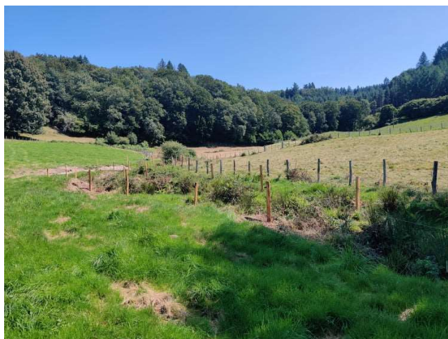
Illustration 12 : Mise en défens d'un affluent de la Maulde (crédit photo : CCCSO)
