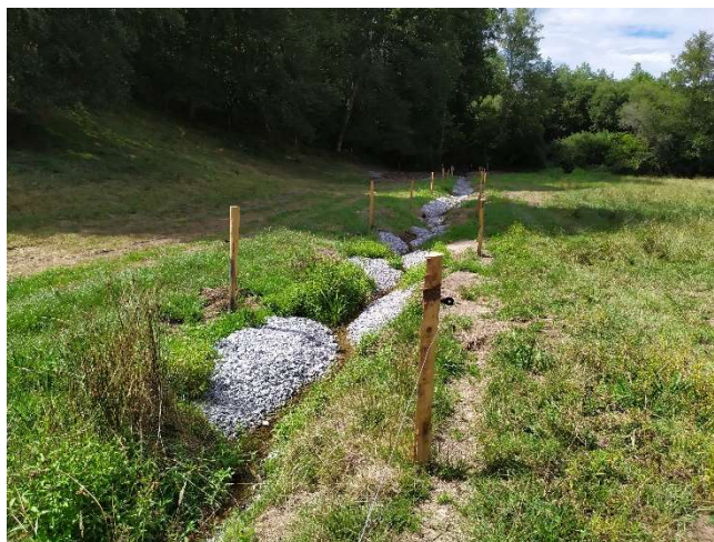
Illustration 22 : Création de banquettes sur un affluent de la Leyrenne (crédit photo : CCCSO)
